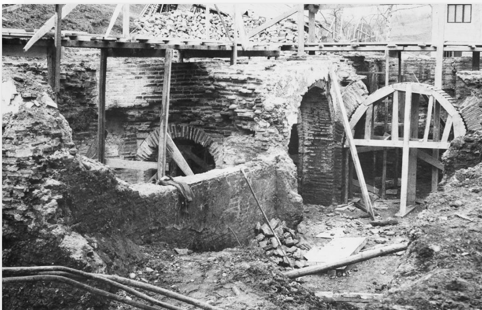
Figura 6. Mănăstirea Clocociov, în reparație, 1976
